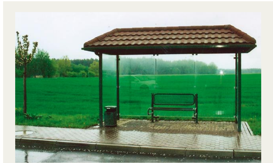
Bild 4: Ein negatives Beispiel der Verwendung von Ausgasungsadditiven zeigt der Schadensfall an einer Buswartehalle
