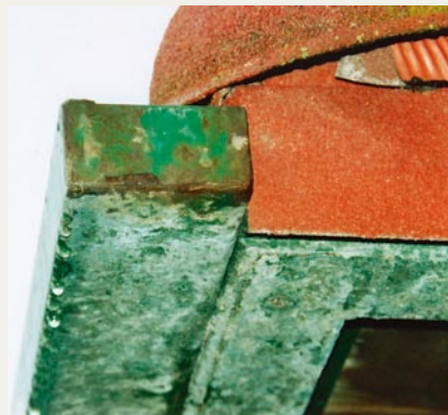
Bild 5: Korrosionsschaden an einem Duplexsystem
