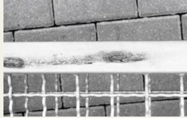
Bild 2: Beim Feinputz durchgeschliffener Zinküberzug
