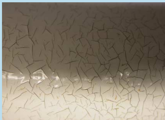
Spannungsrisse an einem Badheizkörper (RAL 9016) im Bereich der Handtuchauflage an der obersten Sprosse
