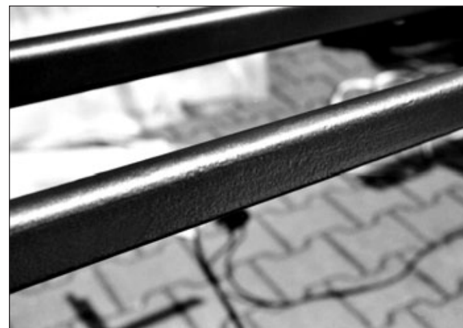
Nach der Pulverlackierung werden Unregelmäßigkeiten im Zinküberzug noch optisch verstärkt.
