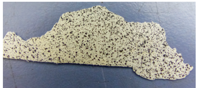
Ein abgelöster Lackfilm mit anhaftenden Rückständen nach mechanischer Oberflächenvorbereitung.
