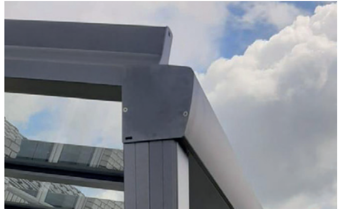
Eine ungünstige Dosierung von Rückgewinnungs- und Frischpulver kann signifikante Schwankungen im metallischen Erscheinungsbild des eingebrannten Lackfilmes nach sich ziehen. In diesem Fall resultiert die uneinheitliche Optik aus Chargenschwankungen des Pulverlacks in DB 703 und unterschiedlichen Applikationszeiträumen mit Rückgewinnungsfahrweise.
