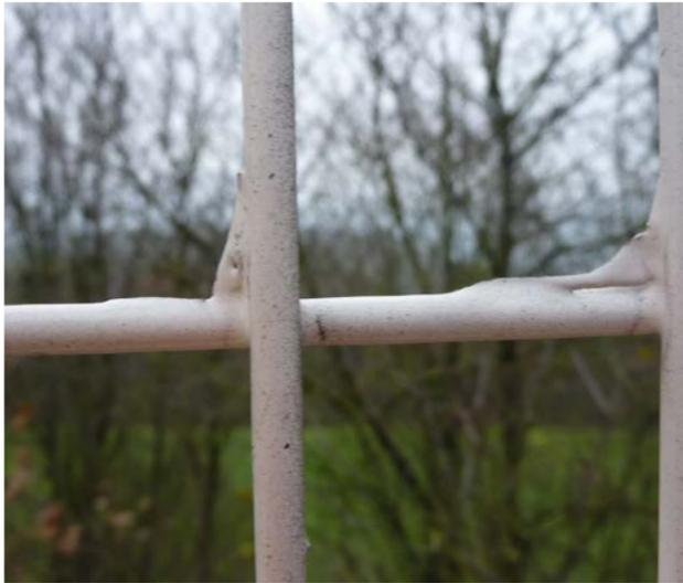
Nahaufnahmen der verzinkten und pulverlackierten Gittersegmente mit deutlich erkennbaren Störungen im Lackfilm aufgrund von nicht ordnungsgemäßem Grob-/Feinputz sowie scharfkantigen Rückständen/Abläufern nach der Verzinkung.
