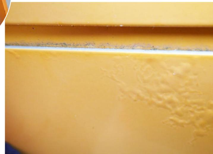
Die Gebäudefassade aus Aluminium auf Island weist Filiformkorrosion auf. ungenauen Vorgaben des Standortes bei der Bestellung beim Lackierbetrieb
