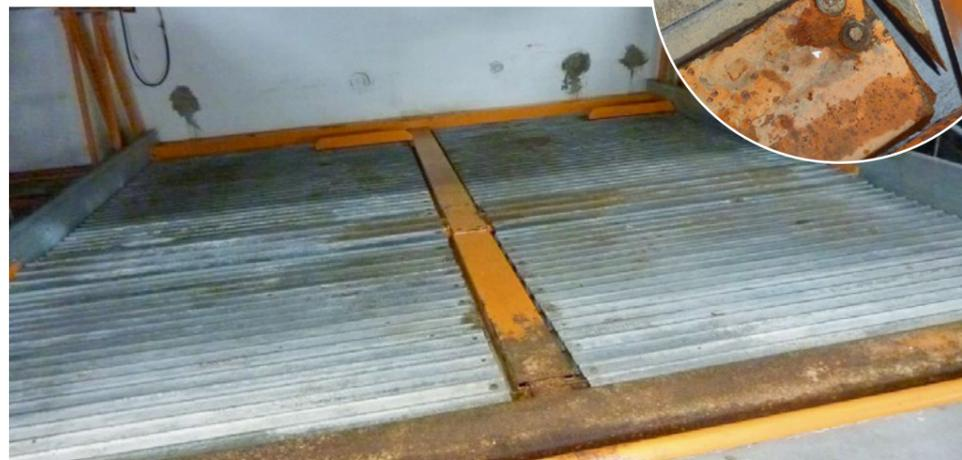
Der Doppelparkplatz in Mischbauweise ist eine einfach pulverlackierte Schwarzstahl-Rahmenkonstruktion mit aufliegenden Zinkblechen. Die Korrosion der Auffahrbereiche ist deutlich erkennbar und eine Folge der Ablagerungen von Auftausalzen mit ständiger Feuchte. Dadurch ist die Tragkraft und die Sicherheit bei Befahrung nicht mehr gewährleistet.
