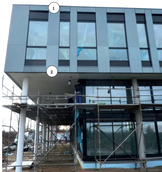
Die Verarbeitungsparameter beim Pulverlackierer können die Effekttöne beeinflussen. So ist bei Position 1 ein RAL 9023 Perldunkelgrau waagrecht hängend appliziert worden, bei Position 2 erfolgte die Beschichtung senkrecht hängend.
