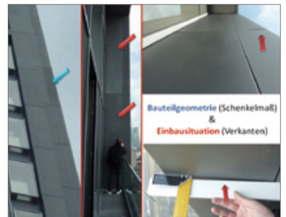
Typische Fehlerquellen: Effekt-Toleranzen (li.), kritische Montagesituationen gegenüber der Pulverbeschichtung (mi.) oder Effektveränderungen durch verkantete Montage (re.). Quelle: Dr. Herrmann
